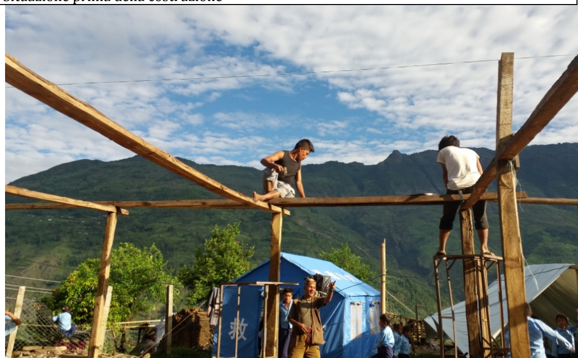
I lavori in una delle scuole
