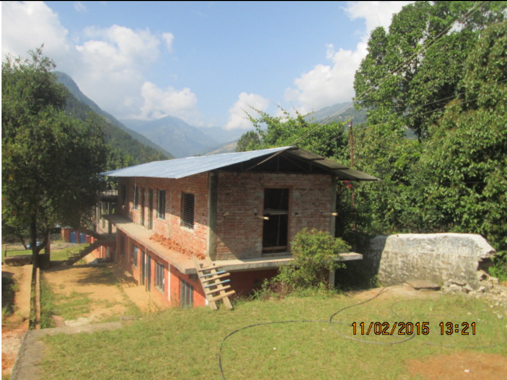
La costruzione della scuola di Laharepowa
