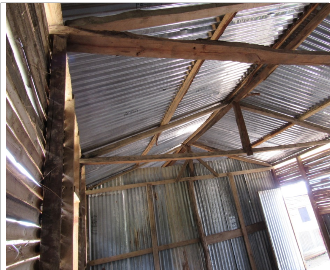
La struttura interna
